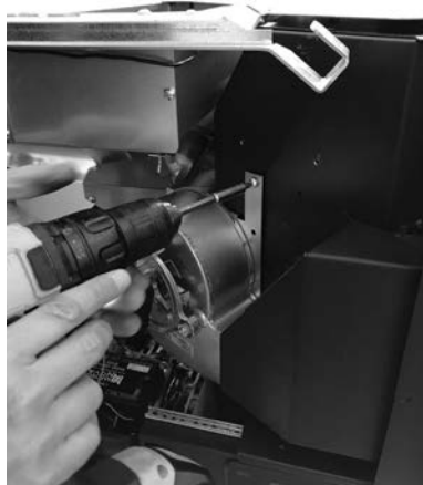
Fig. 45 - Extraiga el ventilador
