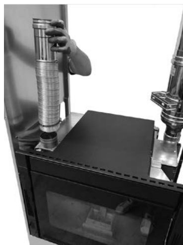
Fig. 68 - Introducción del insertable
