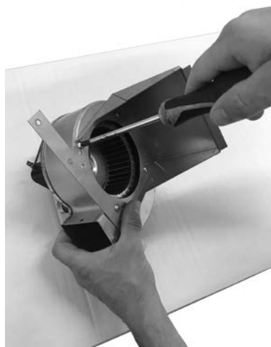
Fig. 49 - Extraer tornillos
