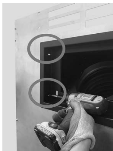
Fig. 74 - Fijación del exterior de la trampilla
