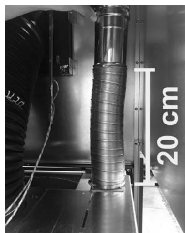
Fig. 56 - Conexión del tubo flexible (vista posterior del insertable)
